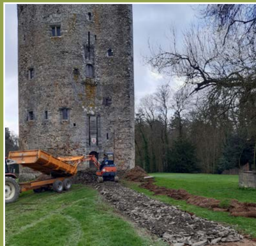
Pendant les travaux
